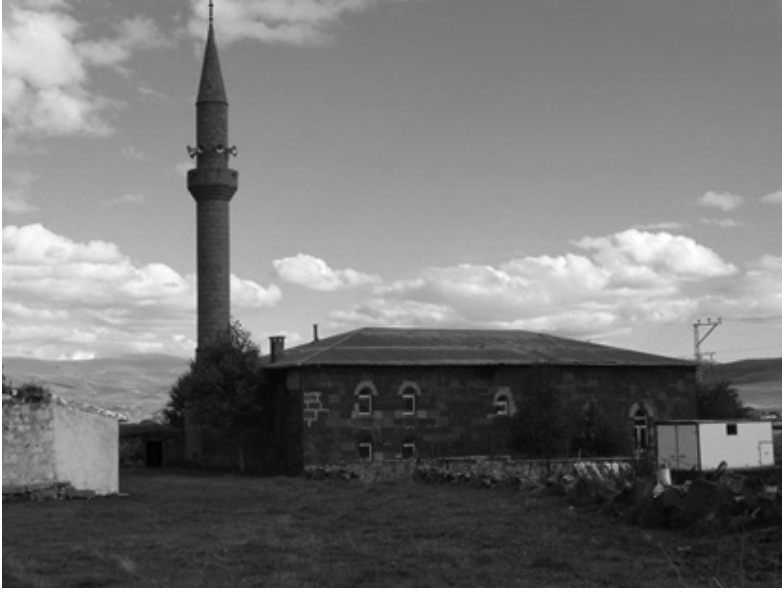
Foto. 6- Suhara Köyü Camii Batı Cephesi.
