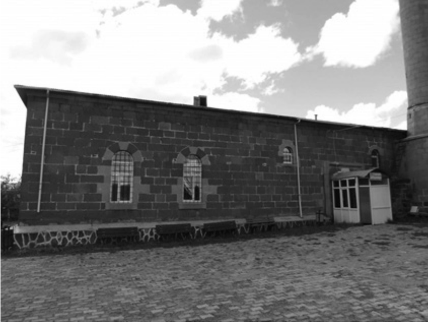
Foto. 2. Suhara Köyü Camii Doğu Cephe.
