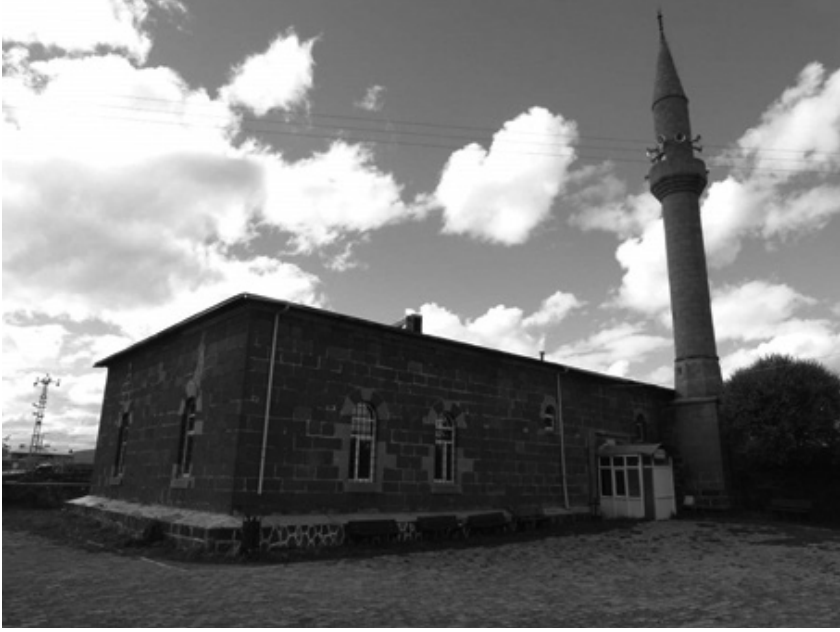
Foto. 1. Suhara Köyü Camii Genel Görünüş.
